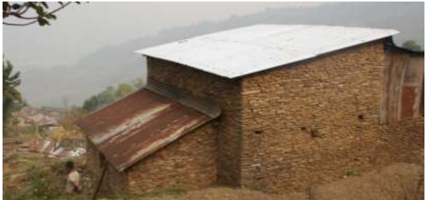
Eines der 92 vom Erdbeben beschädigten Häuser mit der von uns finanzierten neuen Bedachung
