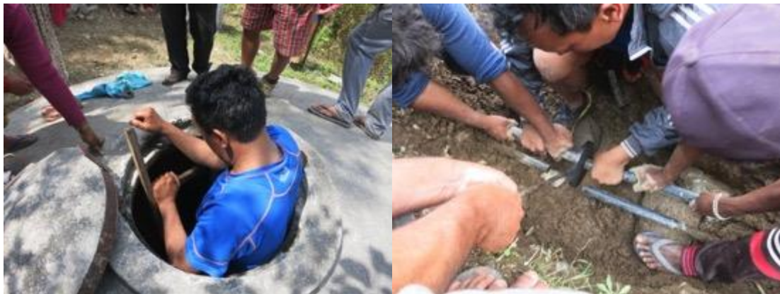
Ein Wasserreservoir wird gereinigt und eine defekte Wasserleitung muss zusammengeschweisst werden
