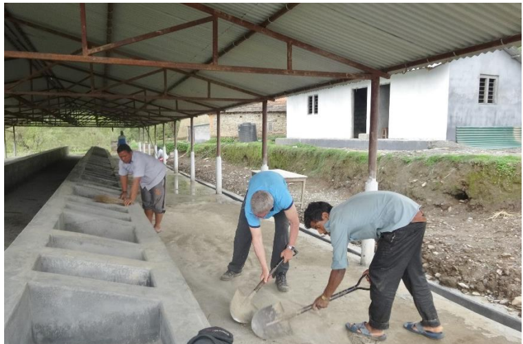
Aktive Mithilfe bei Reinigungs- und anderen Arbeiten während einem Tag unseres Dhital-Aufenthaltes. Im Hintergrund das Nebengebäude für die Lagerung von Futter und das Büro.
