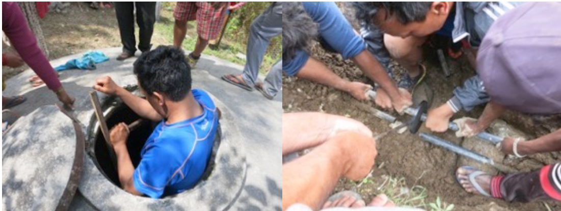
Ein Wasserreservoir wird gereinigt und eine defekte Wasserleitung muss zusammengeschweisst werden
