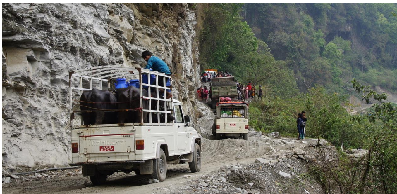
Fahrt nach Dhital – eine neue Strasse ist im Bau
