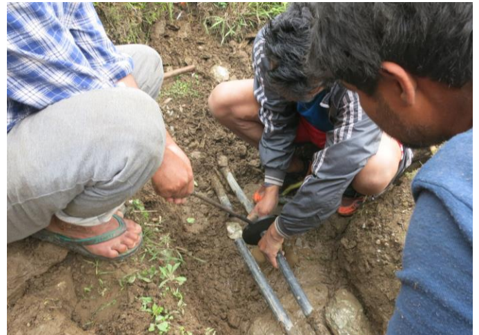
Reparatur einer Wasserleitung mit einem im Feuer erhitzten Eisen.
