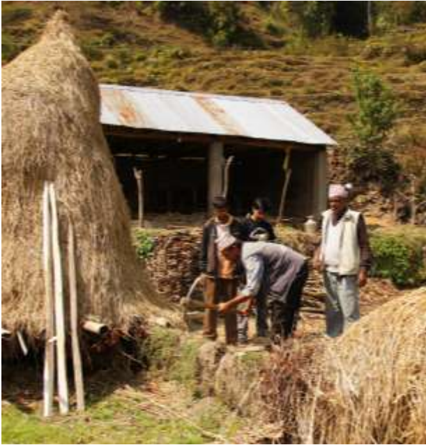
Der Leitungsverlauf wird festgelegt
