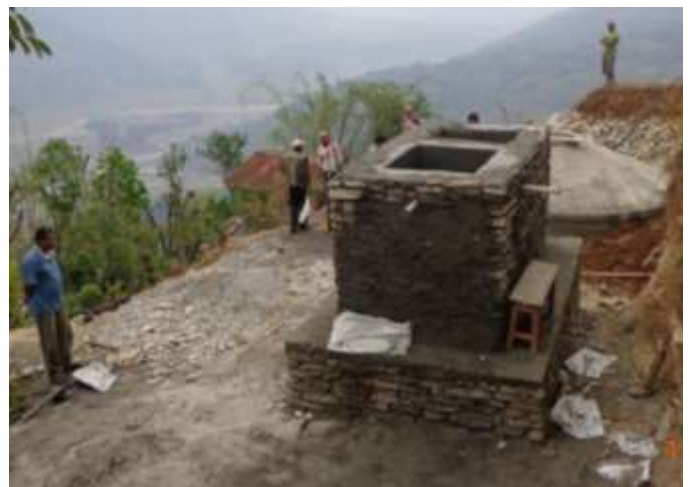
Bau des Verteilerschachts
