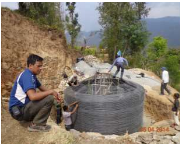
Bau eines der beiden Reservoirs
